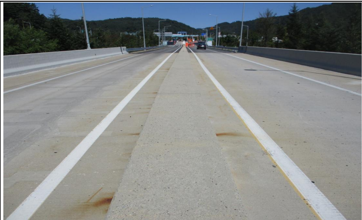
교량 상부 전경
